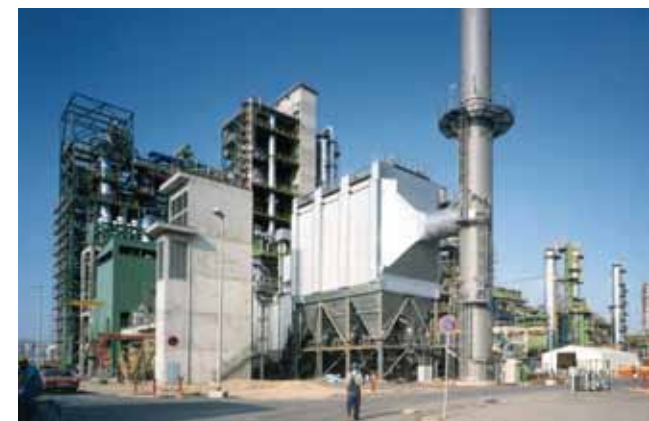
安装中的三电场电除尘器
