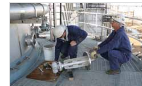
在操作过程中，可以方便地维护、更换喷嘴
