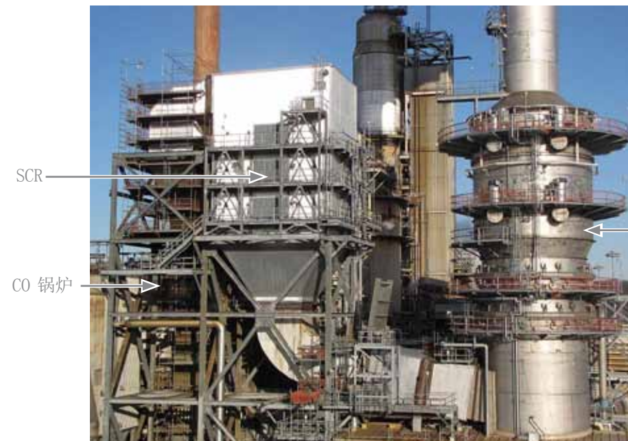
除尘脱硫塔 (湿式电除尘器及脱硫塔)
